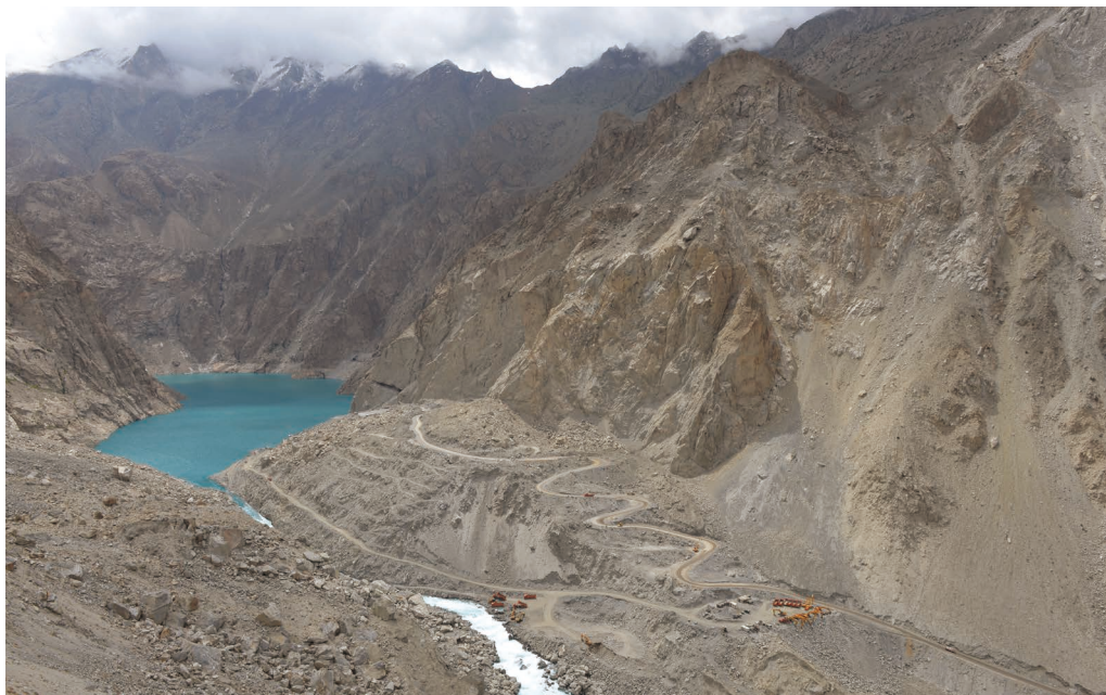
“中巴经济走廊”地质条件复杂,山地灾害频发,影响重大;2010年1月4日,巴基斯坦喀喇昆仑公路 Attabad 村发生巨型滑坡,堵塞洪扎河谷形成5亿立方堰塞湖,破坏和掩埋公路近16公里,摧毁、淹没房屋100多座,20人遇难和失踪,中断交通4年多。项目组前期减灾工作取得良好效果,有力支撑了中巴喀喇昆仑公路的重新开通
