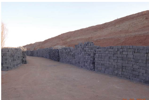
图5 某段长城遗址被铲削后大规模新砌
