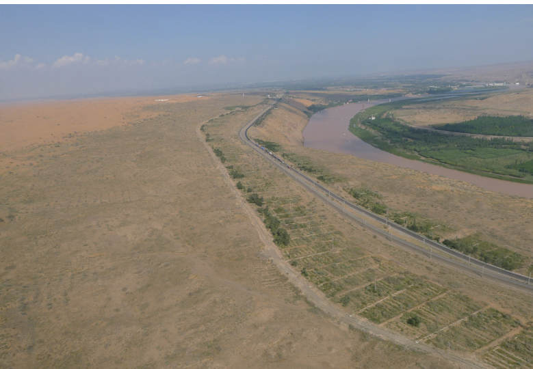
宁夏中卫沙坡头地区包兰铁路人工固沙植被防护体系
