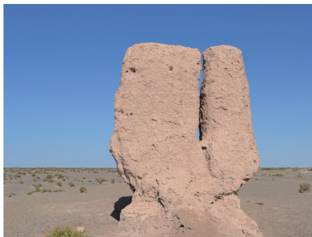
图3 汉长城烽燧遗址基底掏蚀凹进
