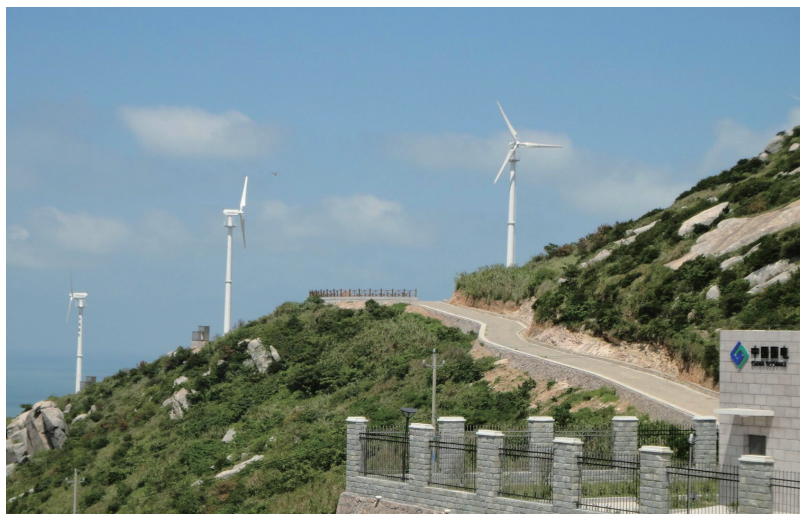
图2 东福山岛接入风光储柴微网发电系统的风电机组
