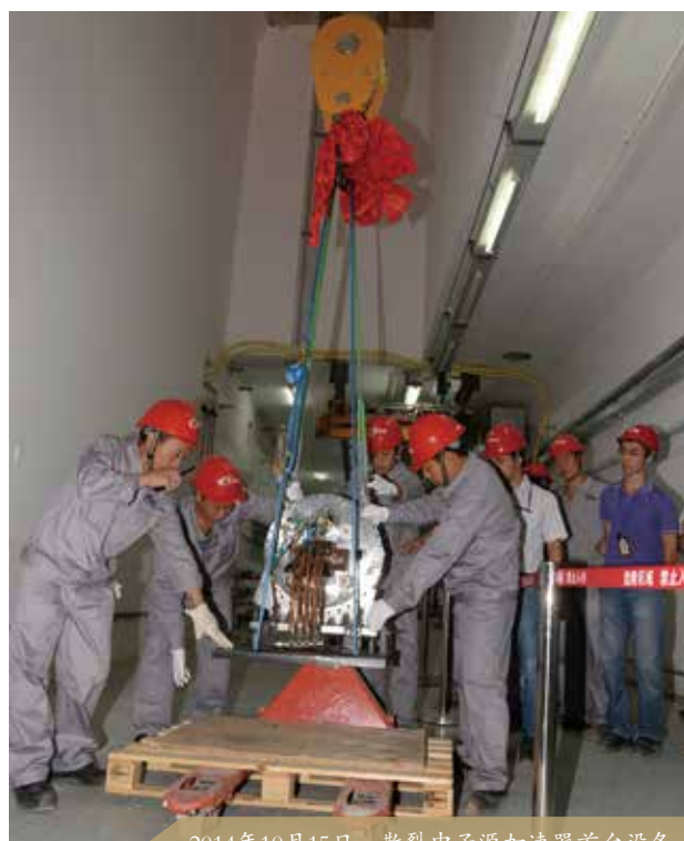
2014 年 10 月 15 日，散裂中子源加速器首台设备——负氢离子源进入隧道安装
