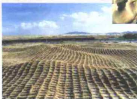
▲ 包兰线沙坡头地段铁路治沙防护体系
