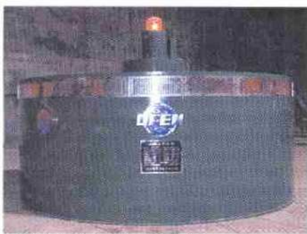
▲400兆瓦蒸发冷却水轮发电机
